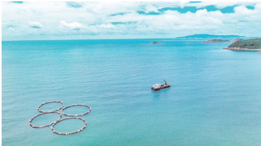
今年6月，重力式網箱在臺山市上川島烏豬洲高冠海域實施網箱固定系統下海安裝工序，這標誌着我市現代化海洋牧場建設邁入新階段。張浩洋攝
